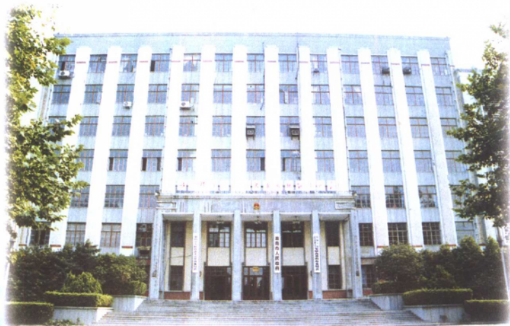
市政府办公楼
