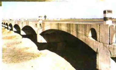
9 阜公路两岭口悬链线石拱桥，3孔，跨径13米， 全长54.955米
