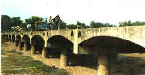
15 京获公路行唐郝河10孔8米钢筋混凝土微弯板拱桥，长86米，宽7米，高1.8米。
