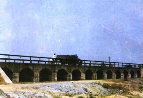
12 建国后，行唐自力更生修建的第一座较大桥梁——跃进桥，长50.3米
