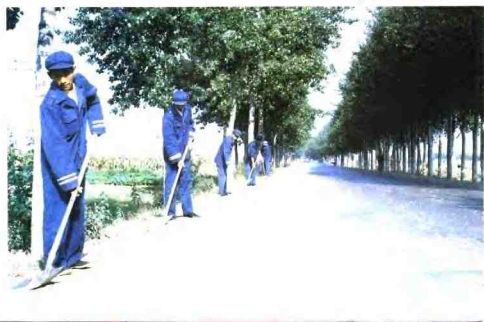
22 威关道班养路员在新口路整修路肩
