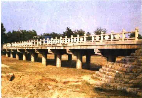
14 曲河桥长72.7米，为10孔6.9米钢筋混凝土筒支板桥。
