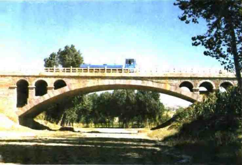
10 行唐单孔跨径最大的桥梁——九口子空腹式石拱桥， 净跨30米，长50米，高7米
