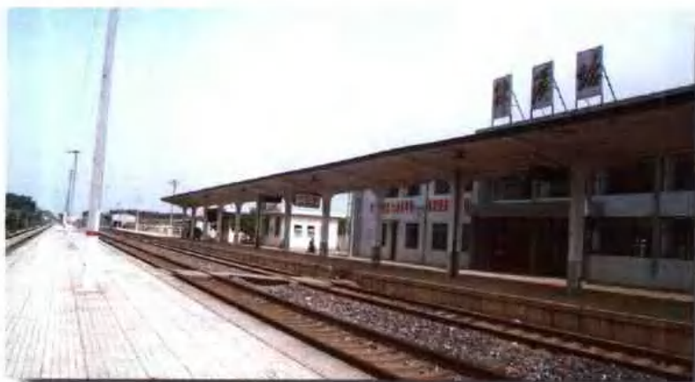
宣杭铁路郎溪火车站
