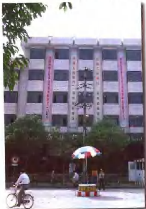
中国工商银行郎溪支行大楼
