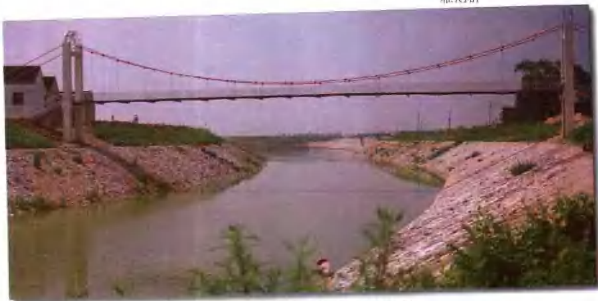
芜太运河定埠段引航道上的斜拉桥
