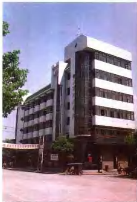
工商行政管理局大楼
