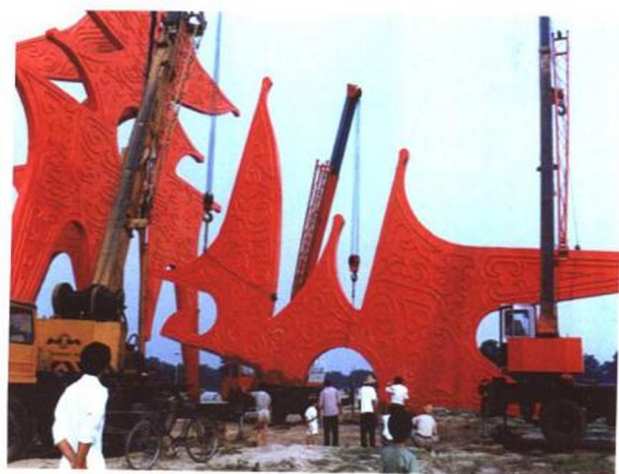
023 《玄鸟生商》傅中望 1997年 雕塑施工现场
