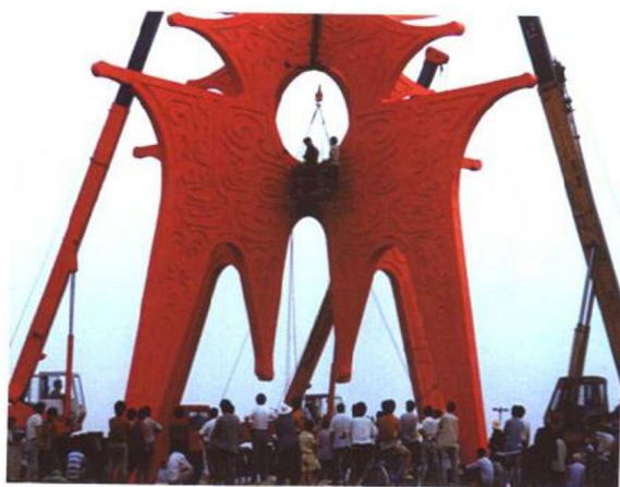
022 《玄鸟生商》傅中望 1997年 雕塑施工现场
