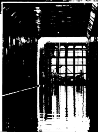
▽ 引滦工程输水隧洞
