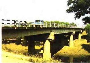
北京至大名公路臧桥公路桥
