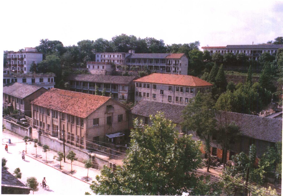
中共枞阳县委机关驻地
