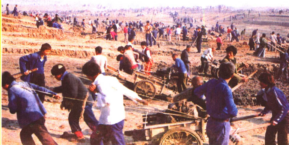
治理流鞍河工地
