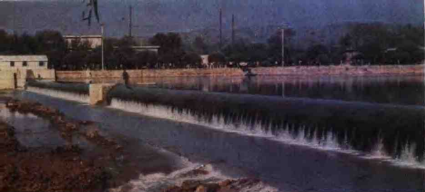
武烈河橡胶坝
