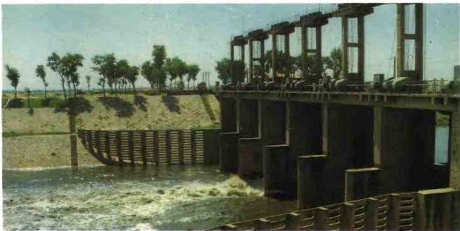
献县枢纽进洪闸
