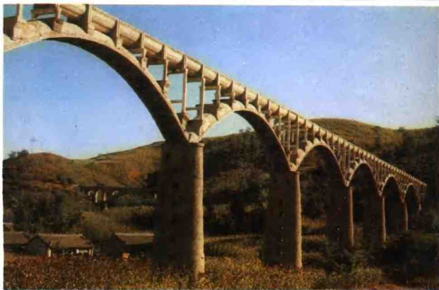
山区跨涧渡槽
