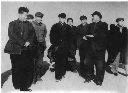
1967 年李先念副总理视察滏阳新河工地
