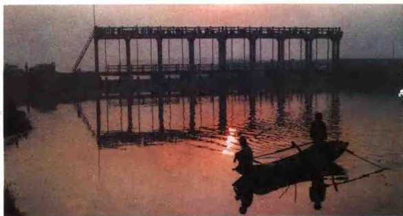
滏东排河五开闸
