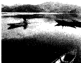
▲总库容 6300 万立方米的九龙甸水库
