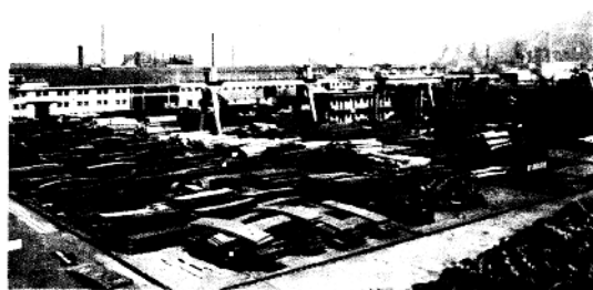
公司半山仓库的露天堆场
