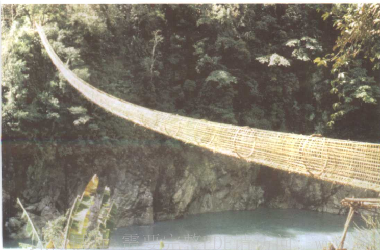
用藤条制造的吊桥， 横跨河上
