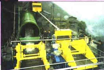
▼正在施工建设中的洗选厂
