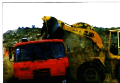
投资 350 万元兴办的大型工程运输车队，正在参加国家重点建设。
