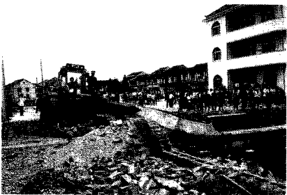
► 拆除非法占地建筑物现场
