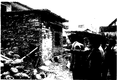
► 副局长周开建深入现场检 查违法占地案件
