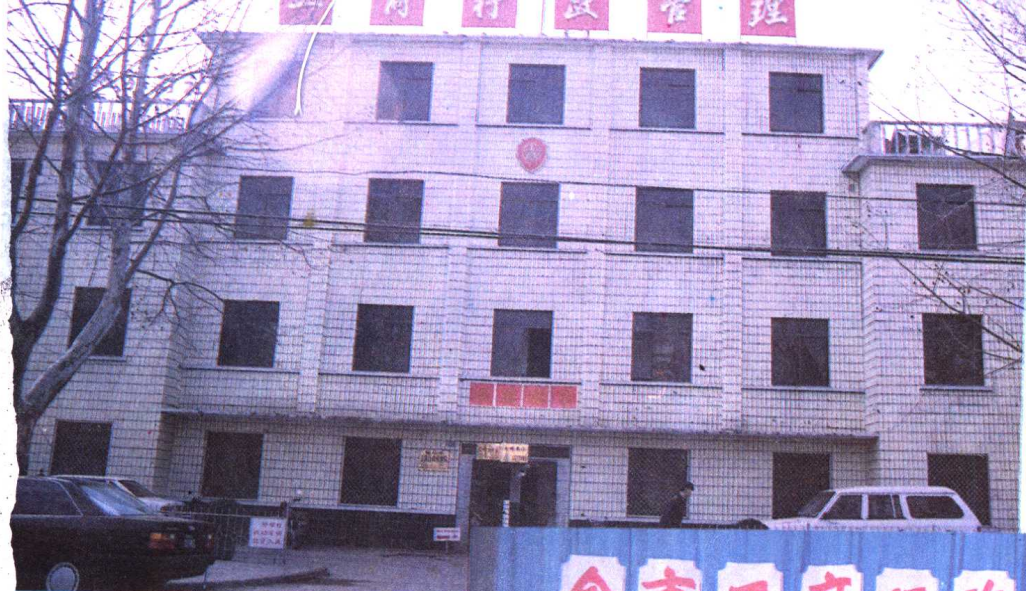
◁淮北市工商行政管理局 办公大楼
