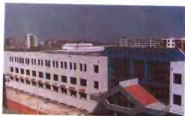
建设中的大明沟农副产品批发市场
