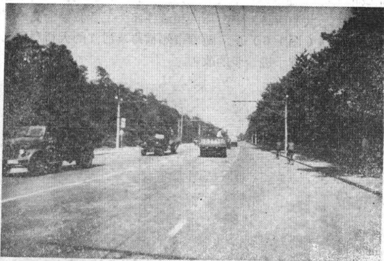
图 1-7 武汉市长江大桥联络线外观
