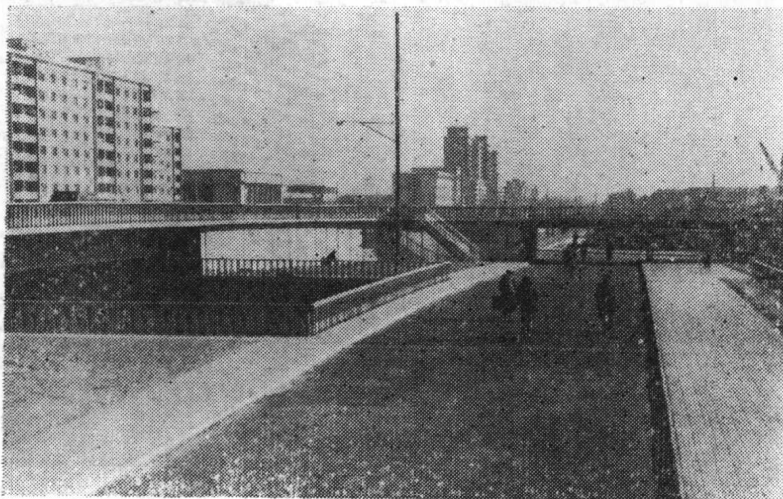
图 1-4 建国门立交中的自行车道
