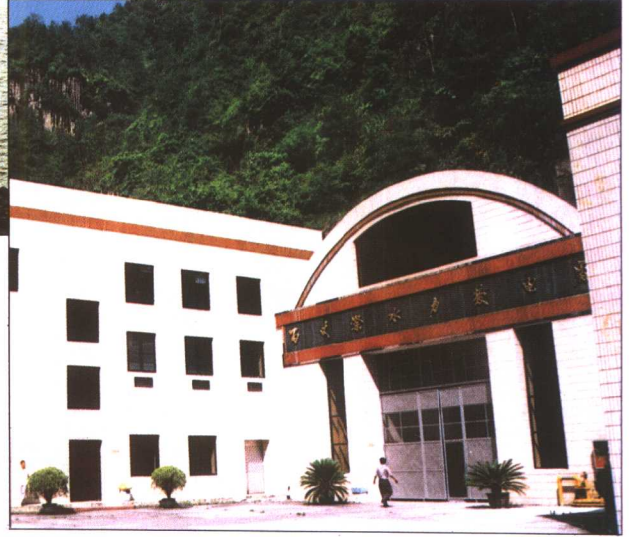
百丈漈水电站
