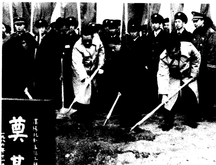
一九八六年十一月六日，国务院副总理李鹏，由省长李长春（右一），沈阳市市长武迪生（左二）等领导同志陪同，为沈阳北新客站工程奠基。
