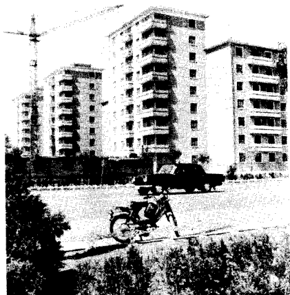
沈阳房地产开发市场异常活跃，数十个住宅小区已经陆续建成。这是在塔湾附近建成的太平庄小区一角。
