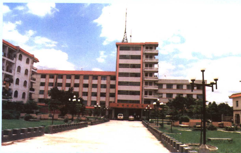
仙游县榜头镇政府大楼
