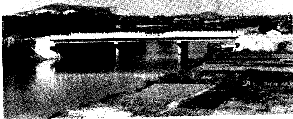
钱胡公路大桥（唐村桥）
