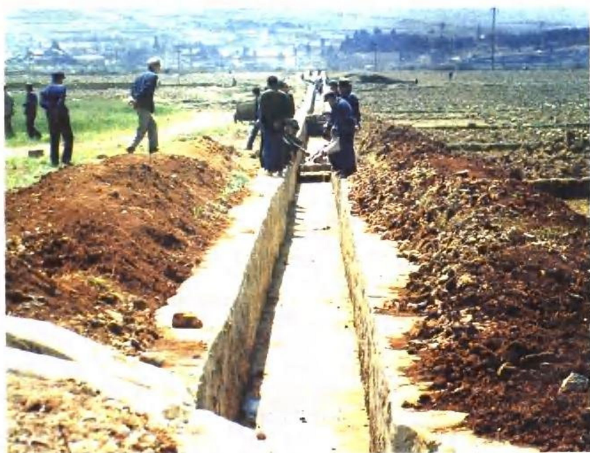
①正在建设中的高产稳产农田
