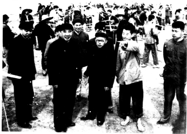
1958年4月与朱德同志在肥西县张公塘水库工地
