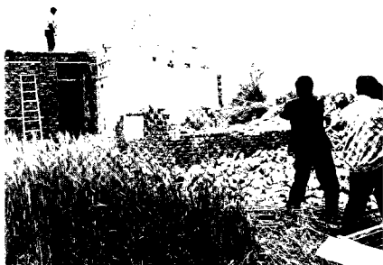
拆除违法占用耕地建房的现场
