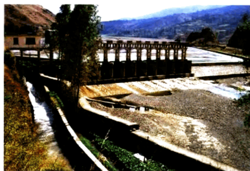
在广南地区广南支水海引水工程，四方集古梁高提水工程。
