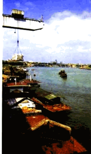
图十二：南宁港北岸作业区
