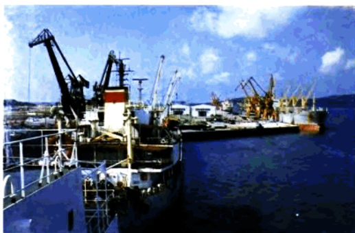
图八：防城港万吨级水泊位
