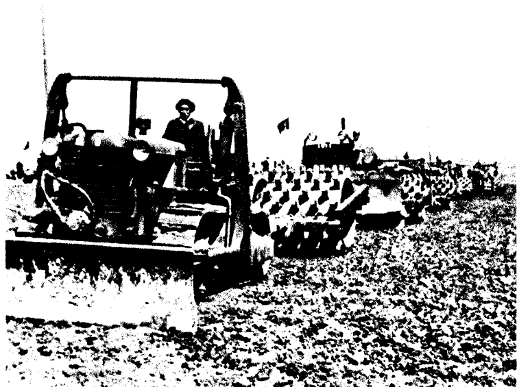
机械化碾压水库大坝。
