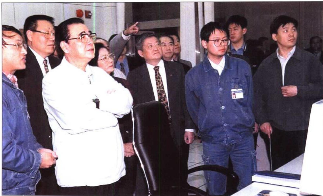
2000年4月17日，中共中央政治局常委、全国人大常委会委员长李鹏在黄河小浪底水利枢纽工程工地考察时，参观电厂控制室
