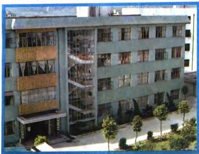
慈溪市农林局办公大楼
