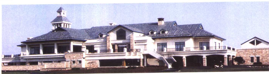
上海汤臣高尔夫会馆屋面金石瓦及内外墙饰面工程
