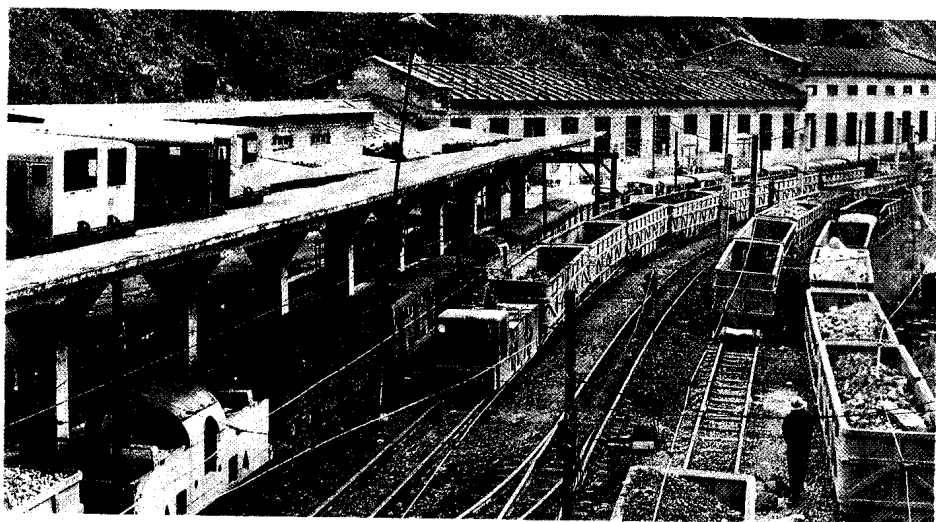
落雪矿运输工区调车场
