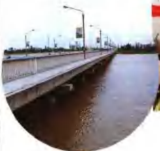
利用世界银行贷款兴建的 南通第一大桥——九圩港桥
