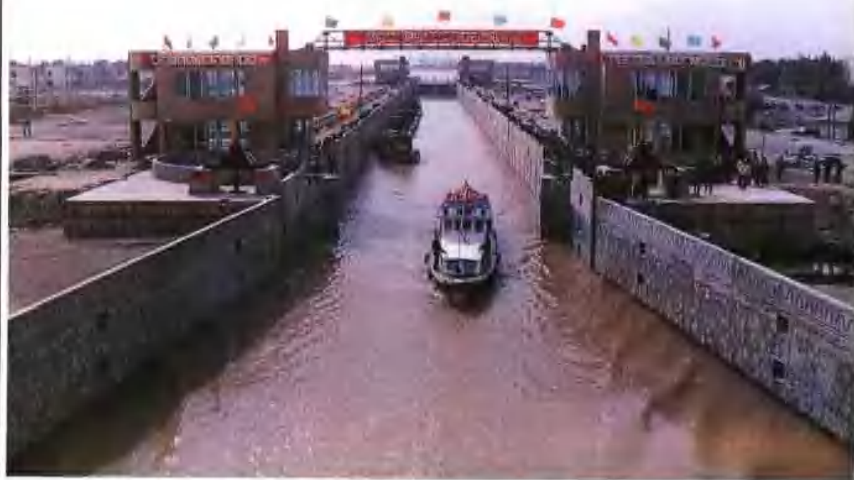
利用世界银行贷款兴建的南通第一大闸——九圩港船闸
