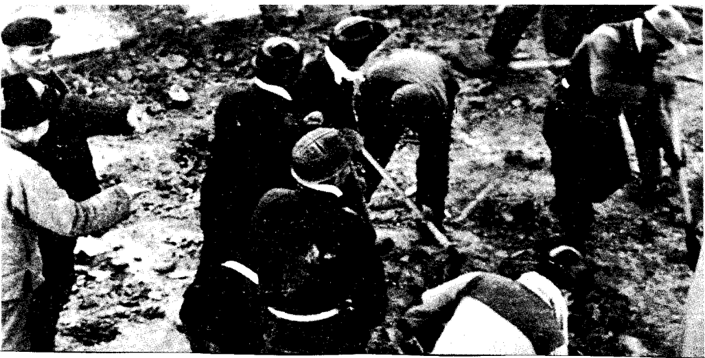
姚桥矿破土动工
