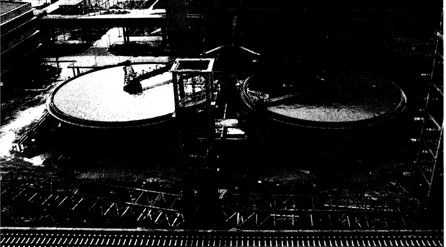
选煤厂污水净化池工程
