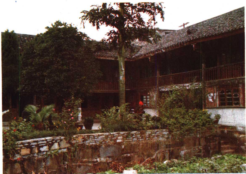
贵州省兴义市泥凼何应钦故居
