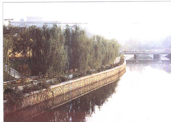
42 北京市西坝河滨河绿地
