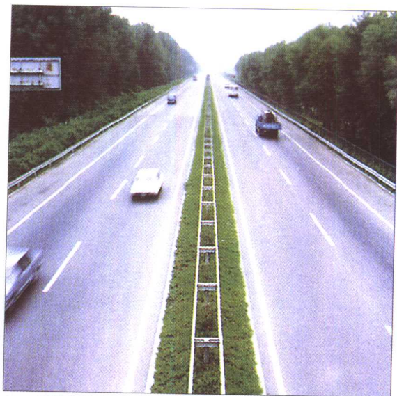
44 沈阳市沈大高速公路中央分隔带
