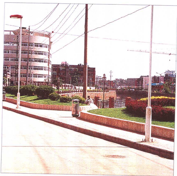
43 昆明市德胜桥桥头绿地
