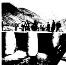
↑ 大理州委欧根等领导在 电站工地。
