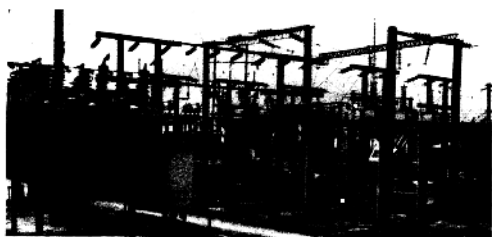
↓老七五35千伏变电站。
