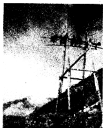
↓ 滇西第一条35千伏输电线路于1959年建成。
