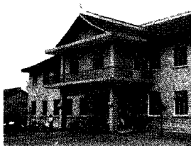
林陵中心卫生院门诊楼
