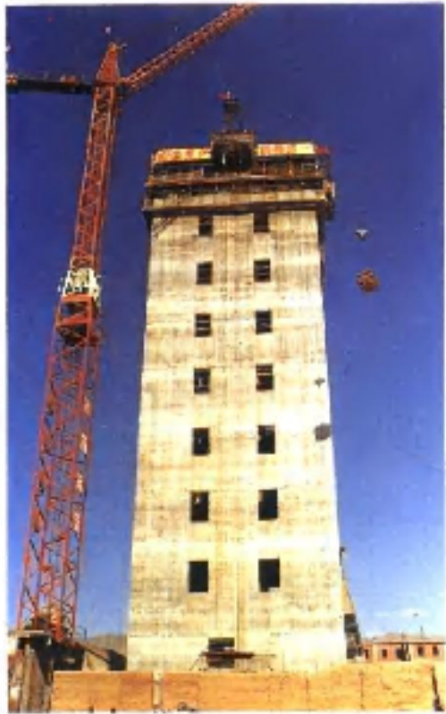
甘肃煤炭第一工程处施工的魏家地立井井塔
