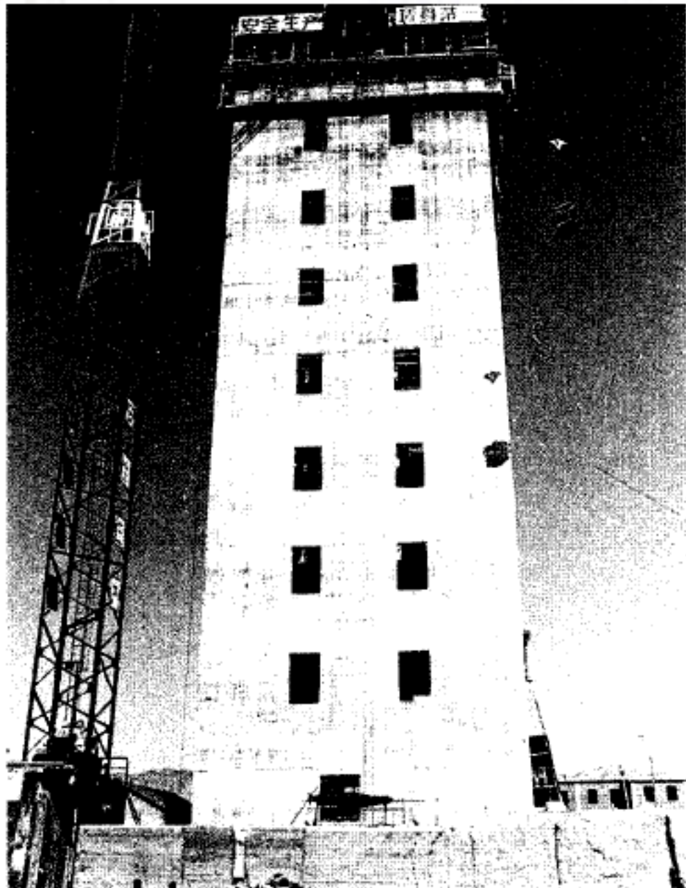
甘肃煤炭第一工程处施工的魏家地立井井塔
