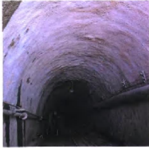
岩巷光面爆破锚杆砼喷浆联合支护巷道
