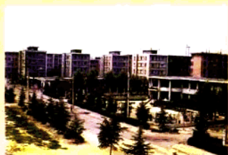
▷九十年代装沟矿单职工公寓楼
