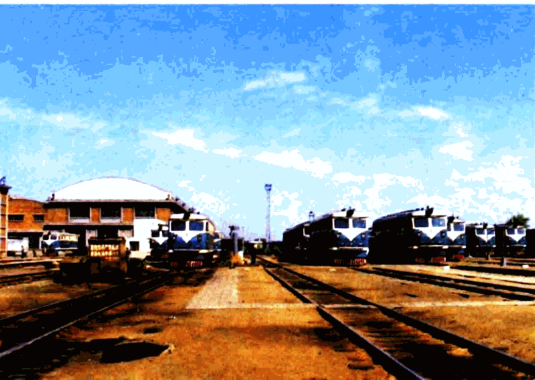
▽ 新建三棵树机务段内燃库 赖亦武 摄
