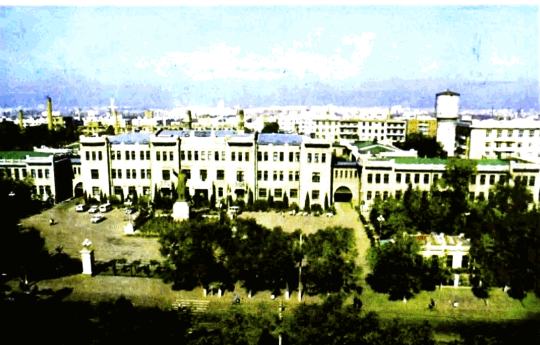
哈 尔 滨 铁 路 局 机 关 大 楼 全 景
