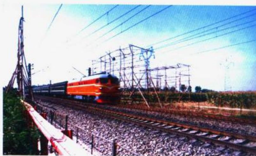
■跨铁路线路架设
