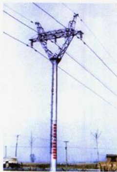
■钢管电杆广泛应用于城乡电网改造和邮电通讯线路
