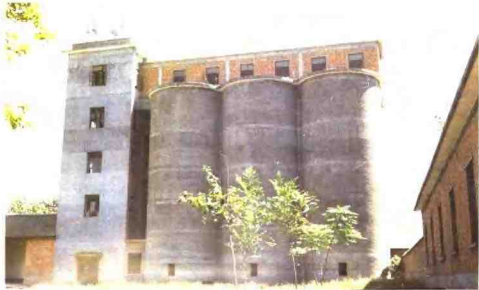
南阳面粉厂立筒仓
