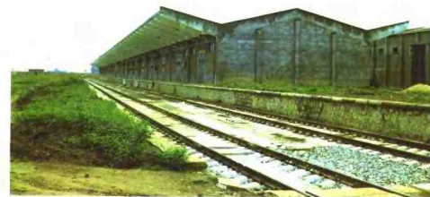
邓县粮食转运站罩棚仓与铁路专用线
