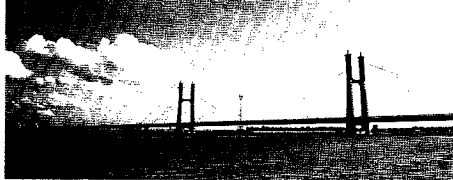
▲东营胜利黄河大桥是联接黄河南北的重要交通纽带
