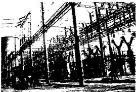
◀济宁市是新兴的能源基地。图为济宁发电厂一角。
