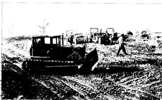
沪宁高速公路吴县段 土地复垦整治现场
