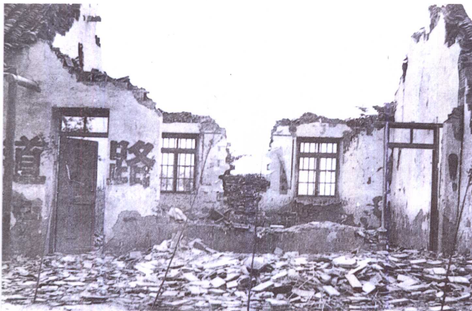
溧阳大溪黄山小学房倒屋塌。
