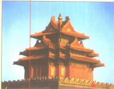
故宫环抱，平面矩形的南北宫墙，宫墙四角建有角楼，这些角楼的造型奇特而复杂，甚中心点，平面呈凸字形的重檐十字歇山殿，面阔三间，进深四间，两側两小间及廊庑实际为半间。小殿面西各辟西间一间的垂拱歇山殿。故宫角楼的复盖形态和单调的城墙形成了鲜明对比。尤其在阳光下，角楼明暗变化丰富，体味感极。
