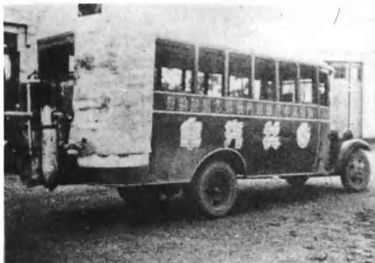
图5 省公路局 机械厂制造的木 炭炉汽车
