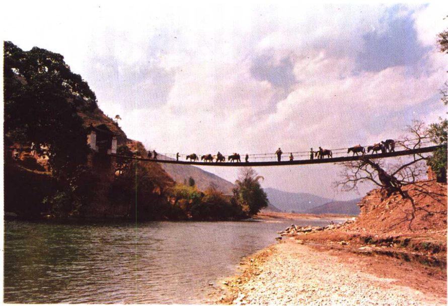
博南古道漾濞铁索吊桥 施作模摄
