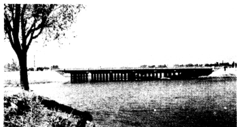
温榆河上的沙河镇南大桥。
